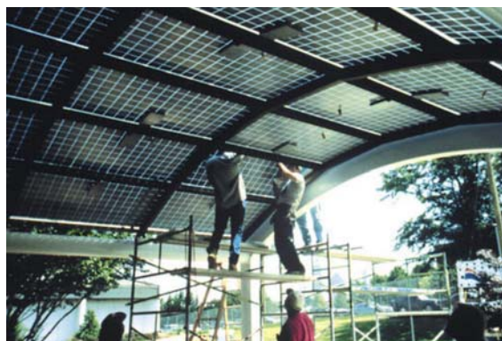
Photo 4. AC PV Modules (Photo Courtesy of NREL).
